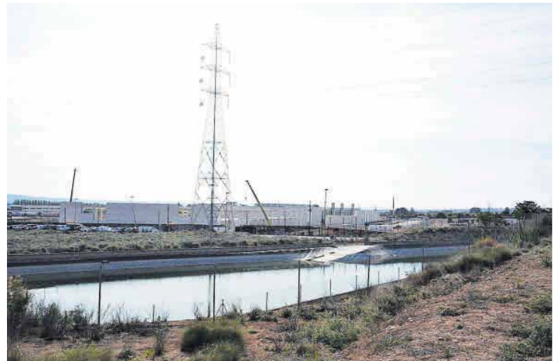
Construcción de un centro de datos de Amazon Web Services en El Burgo de Ebro.
