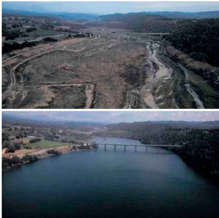
Arriba, el embalse de Rialb en febrero de 2024. Abajo, ayer al 99% de su capacidad. ALBERT GARCIA
