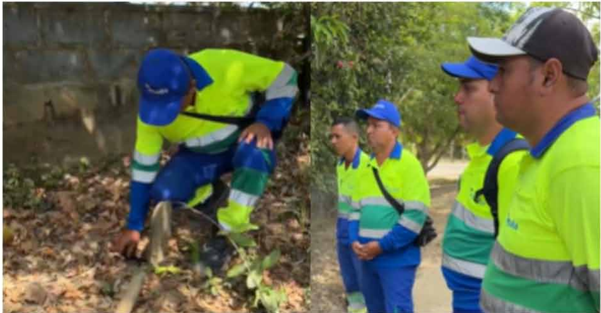
Imagen – trabajos de Aqualia
